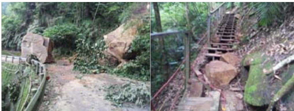
圖 3 天梯聯外道路與園區內落石坍方道路中斷情況 (南投縣政府觀光處)
